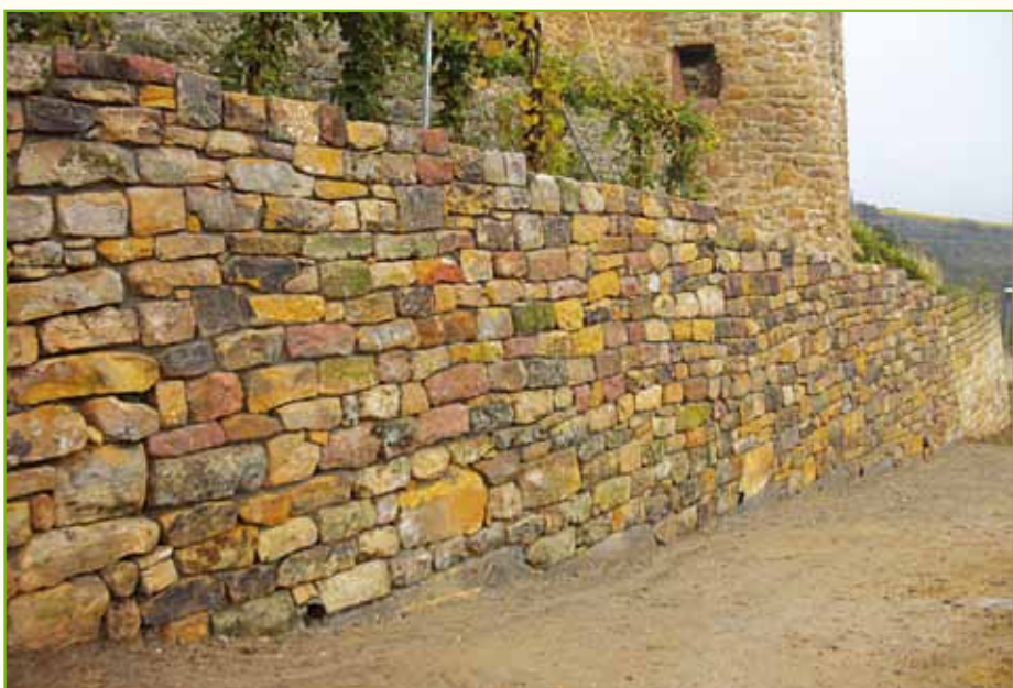
Die zum Teil eingestürzte Mauer am Süd-Ost-Turm musste abgetragen und neu aufgemauert werden.
