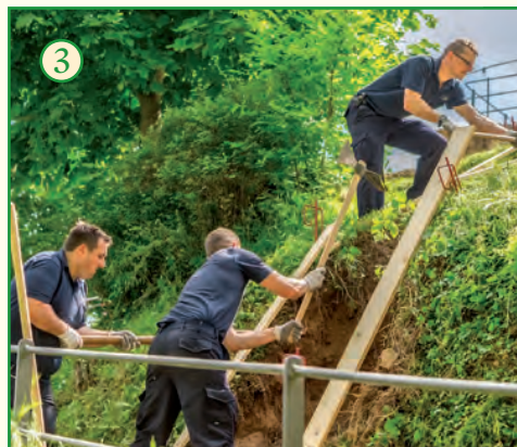
Abb. 3 und 4: Sondierungsgrabung an der Zwingmauer
