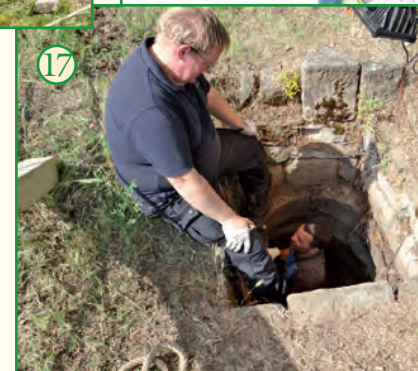
Abb. 16 und 17: Gerüstbau im Zisternenschacht zu dessen Sanierung.
