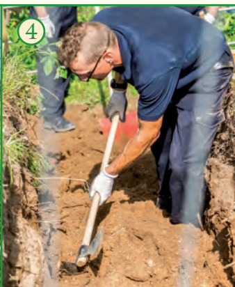
Abb. 3 und 4: Sondierungsgrabung an der Zwingmauer
