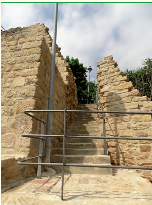
Blick zur Treppe die durch die historische Mauer führt.
