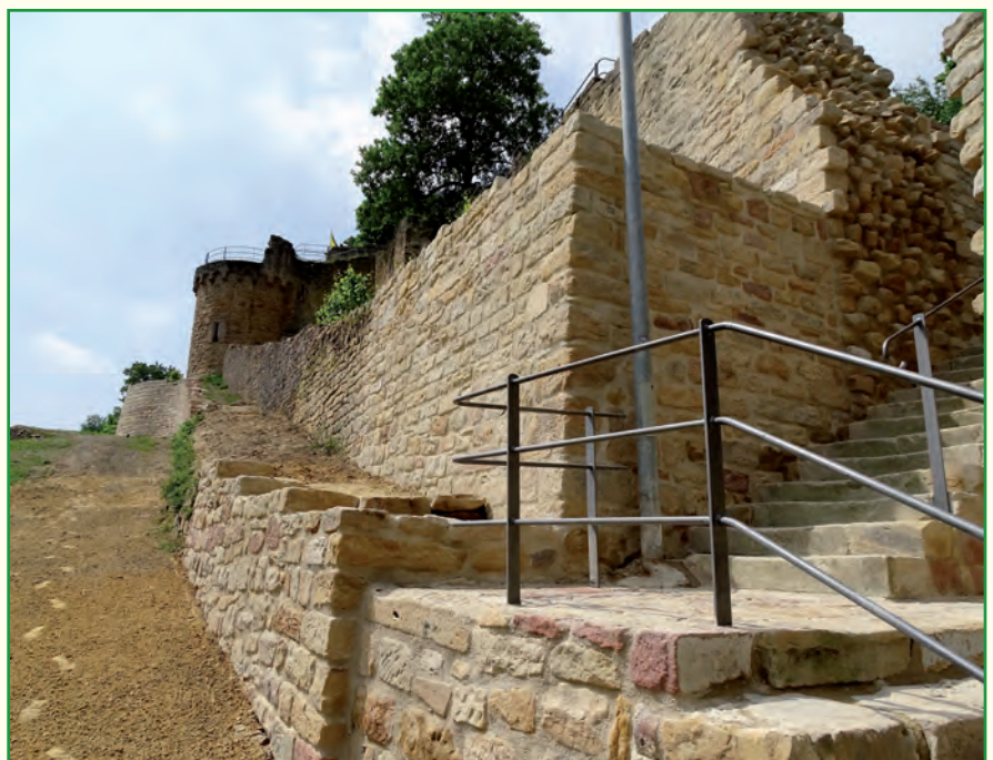
Im Vordergrund die zwei neuen Stützmauern.
