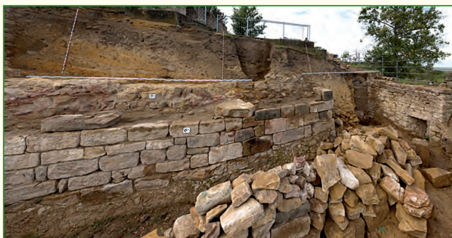
Freigelegte historische Mauer - Foto: Förderkreis
