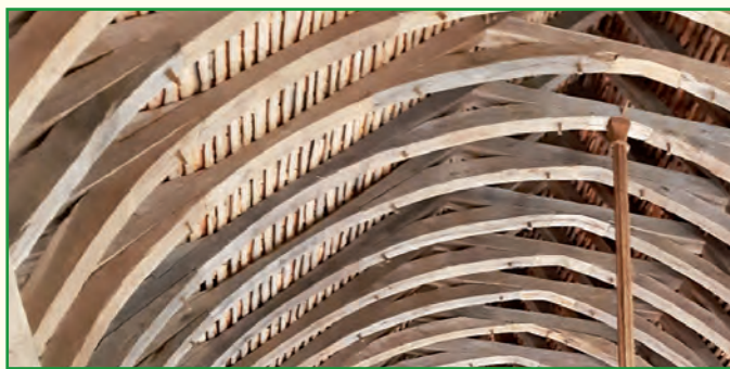
Holzkonstruktion über dem Rittersaal - von Hand hergestellt
