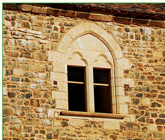
Fenster des Palas
