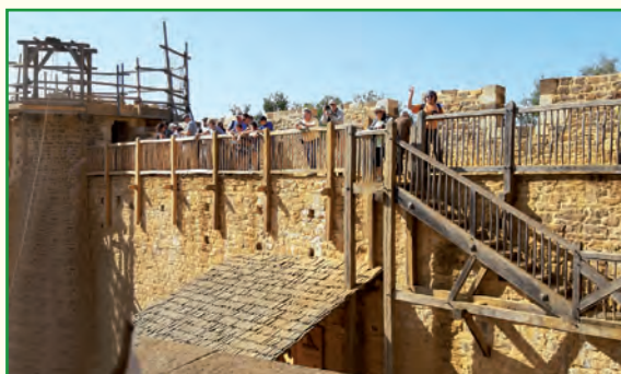
Der fertige Wehgang
