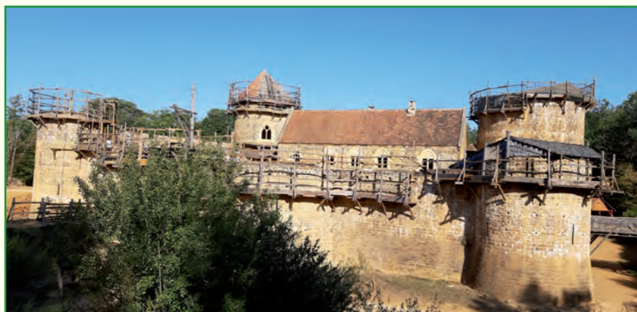
Die Burgenbaustelle im Jahr 2019
