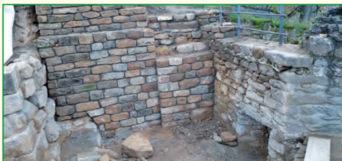
Ringmauer Ost mit Schießcharte und neu hergestellter Sandsteinmauer - Foto: Förderkreis
