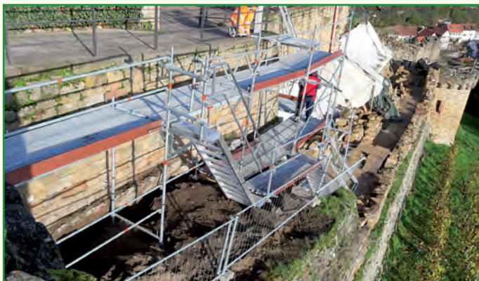
Gerüst zur Vorbereitung der Sicherung der Stützmauer vor der Gaststätte Foto: Förderkreis
