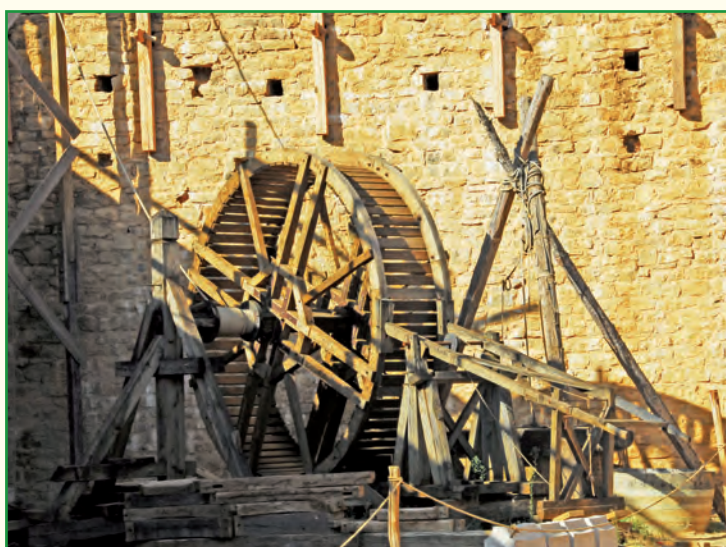
Das Tretrad des Krans zur Beförderung schwerer Lasten
