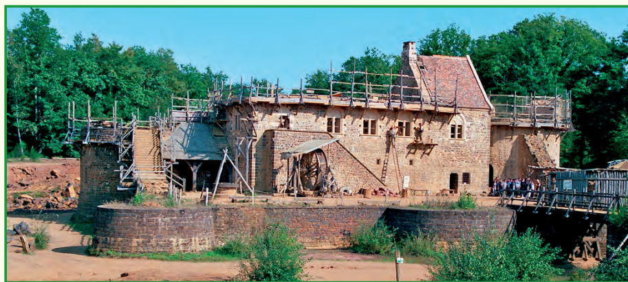
Die Burgenbaustelle im Jahr 2009
