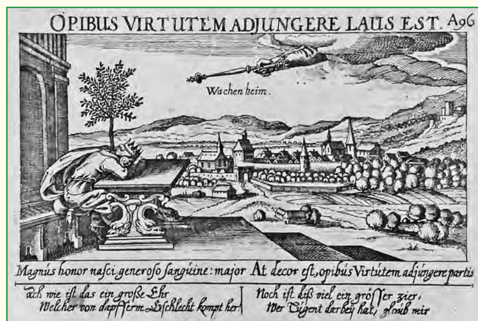
Abb. 1: Reminiszenz vergangener Zeiten – Blick auf Wachenheim mit der ältesten Burgansicht von 1624 im Hintergrund (Mauern und Turm noch weitestgehend intakt; Abb.: Bestand D. Weilacher).
