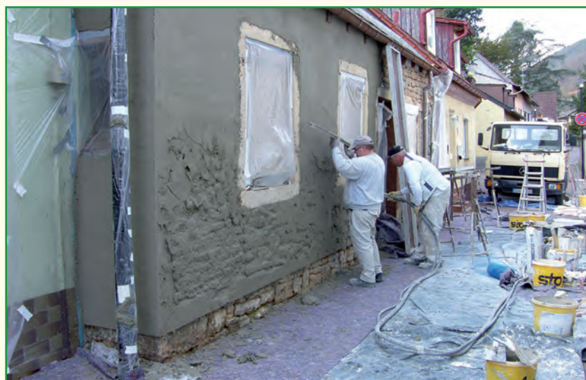
Schloßgasse 21; Verputzarbeiten - Fotos: Förderkreis
